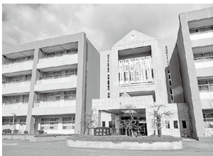
〈写真2〉福岡県立城南高校の正面玄関
